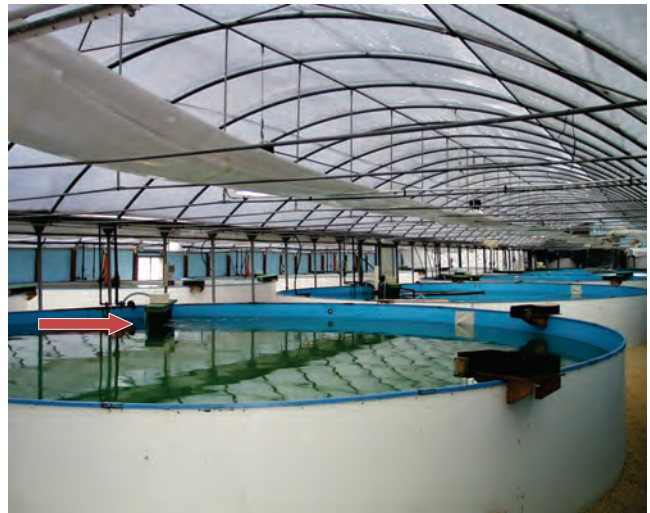
Fig. WP1.2.2.3 Sistema di vasche 'Grandi Volumi' localizzato in una serra di tipo agricolo. La freccia indica il posizionamento dell'air-lifter o ossigenatore.
