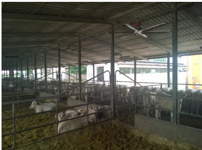
Figura 1. Ventole orizzontali in allevamento di bovini da carne all'ingrasso
