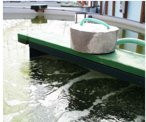
Fig. 6 Particolare della porzione superiore dell'ossigenatore (areatore), priva dello schiumatore.
