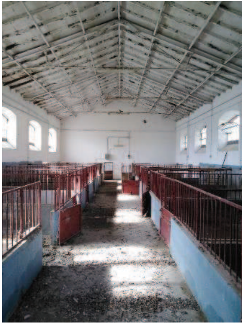
Interno attuale della struttura
