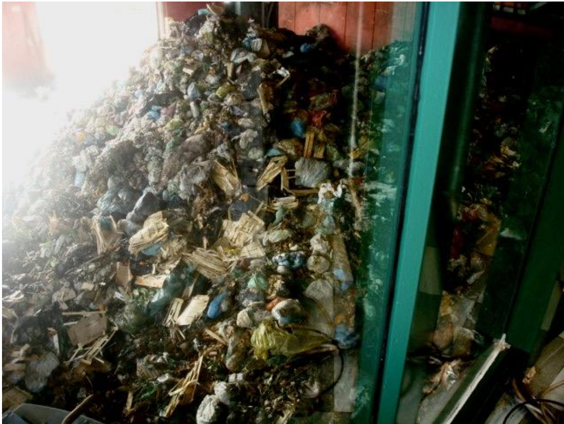
Impianto di compostaggio dell'AMA
