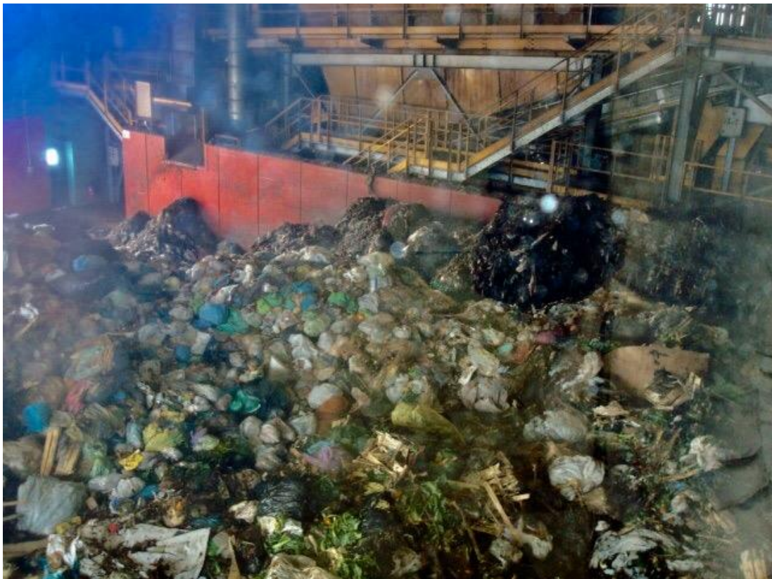
Impianto di compostaggio dell'AMA
