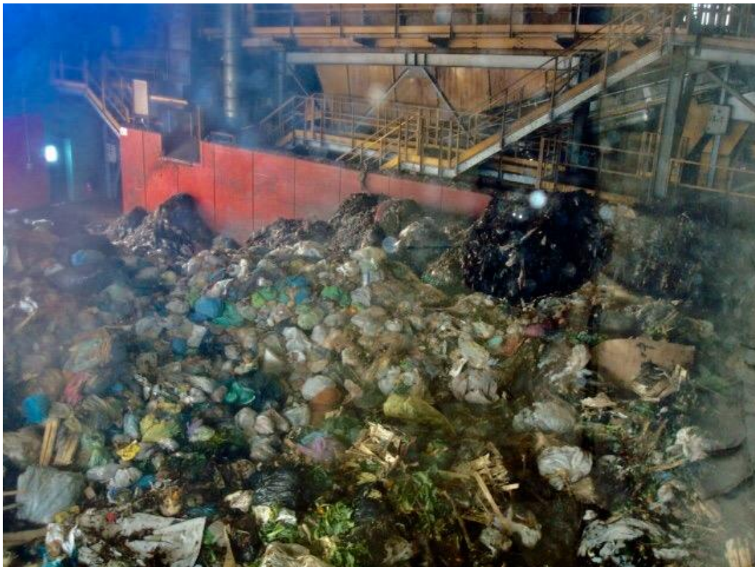
Impianto di compostaggio dell'AMA
